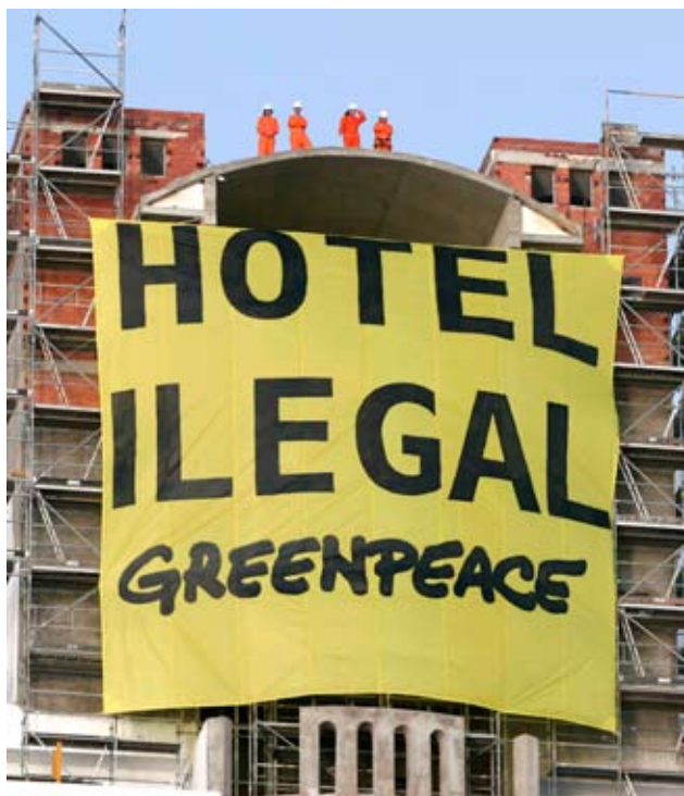
16/11/2005 - Una treintena de activistas del grupo ecologista Greenpeace protagonizan un acto de protesta en el hotel de "El Algarro-bico", en Carboneras (Almería), en cuya obra desplegaron varias pancartas reclamando la demolición de este edificio que se estaba construyendo en el parque natural del Cabo de Gata-Níjar. EFE / Carlos Barba
